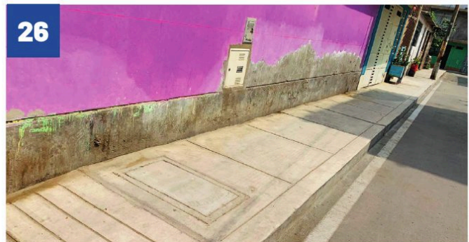
VEREDAS CALLE 1 ZONA A, HUAYCÁN
