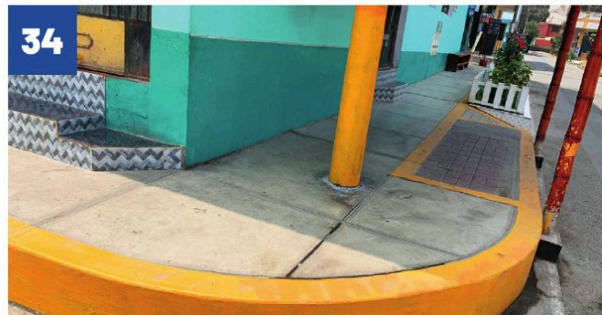
VEREDAS CALLE 8 ZONA A, HUAYCÁN
