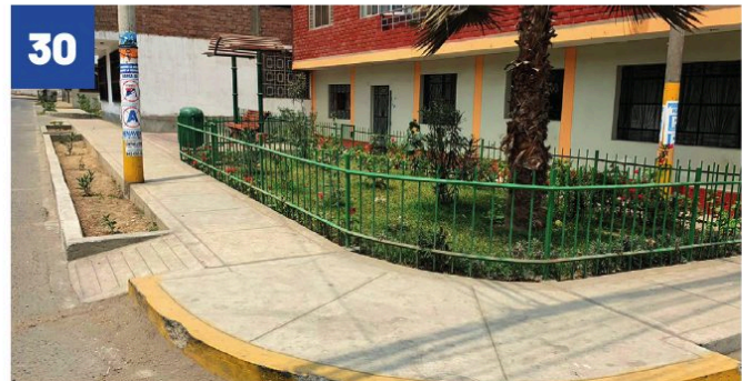
VEREDAS CALLE 5 ZONA A, HUAYCÁN
