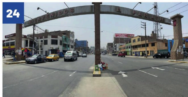
PISTAS AV. JOSÉ CARLOS MARIÁTEGUI TRAMO CARRETERA CENTRAL - AV. LOS INCAS
