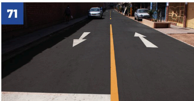
71 PISTAS EN LA CALLE 4 (TRAMO: AV. SANTA ROSA - CALLE 9 DE LA ASOC. DE VIV. COMPRADORES DEL PORTAL DE SANTA CLARA)
