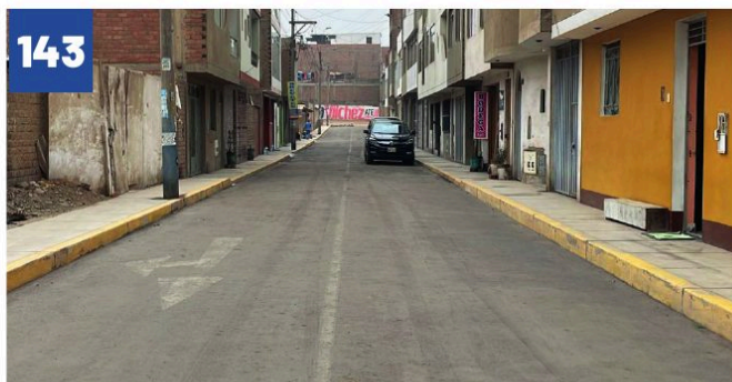
PISTAS CALLE INTERNAS ASOC. CASA GRANDE
