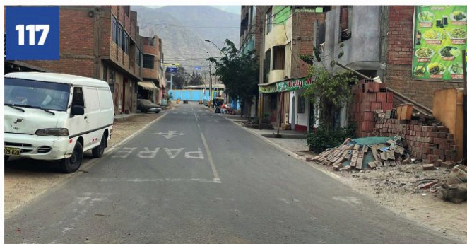
PISTAS CALLE 2 ASOC. DE VIV. AMPLIACIÓN I
