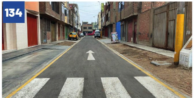
PISTAS EN LA CALLE 3 PROG. DE VIV. RESIDENCIAL LAS MERCEDES DE ATE III ETAPA
