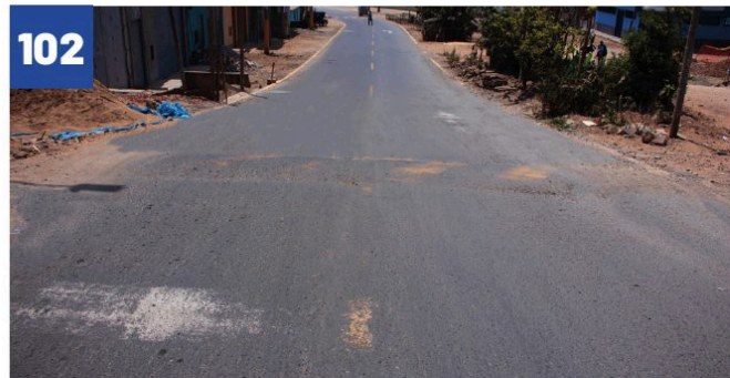
PISTAS EN LA AV. ALFONSO UGARTE (TRAMO: AV. JOSÉ A. QUIÑONES - PASAJE S/N)
