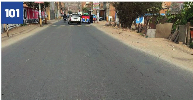
PISTAS EN LA AV. DANIEL ALCIDES CARRIÓN (TRAMO: CALLE 12 - CALLE 14)
