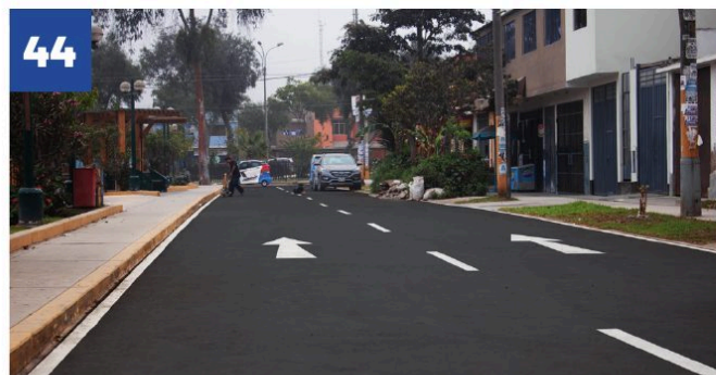
PISTAS EN LA CALLE S/N (FRENTE A LA MZ. M) COOP. DE VIVIENDA MANYLSA
