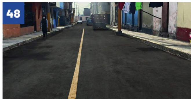
PISTAS EN LA CALLE MANCO CÁPAC URB. SANTA CLARA
