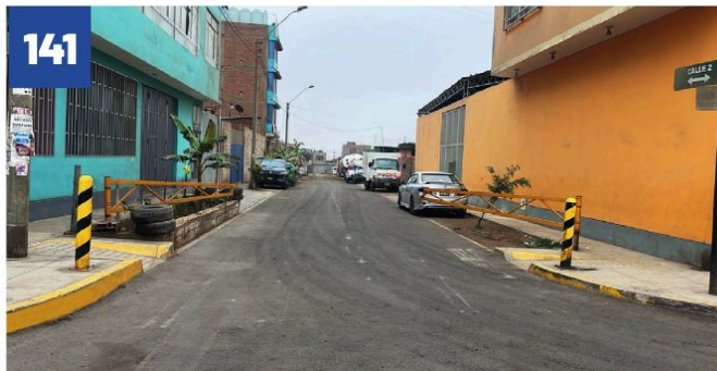
PISTAS EN LA CALLE INTERNAS ASOC. DE VIVIENDA VILA
