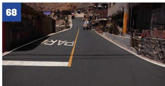
68 PISTAS CALLE 13 ASOC. DE VIV. HIJOS DE APURÍMAC-II ETAPA
