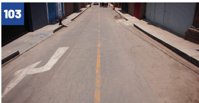
PISTAS CALLE INTERNA URB. SARITA COLONIA
