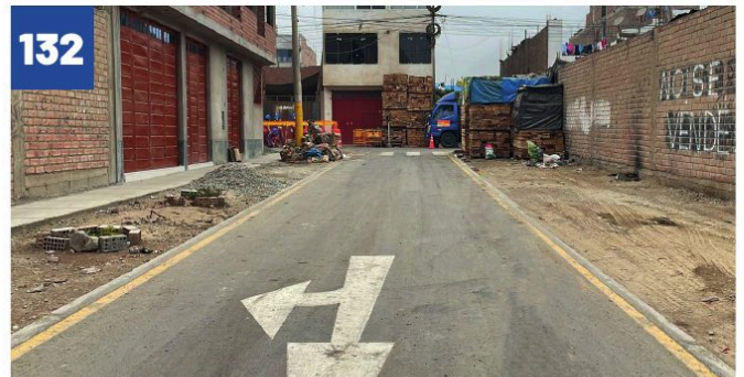
PISTAS CALLE 1 PROG. DE VIV. RESIDENCIAL LAS MERCEDES DE ATE III ETAPA
