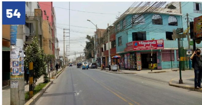
PISTAS EN LA AV. JOSÉ CARLOS MARIÁTEGUI, TRAMO: AV. NICOLÁS AYLLÓN - AV. NICOLÁS DE PIÉROLA
