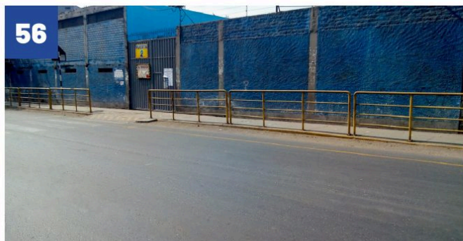
PISTAS EN CALLE 24 DE OCTUBRE, TRAMO: AV. JOSÉ CARLOS MARIÁTEGUI - AV. NICOLÁS DE PIÉROLA
