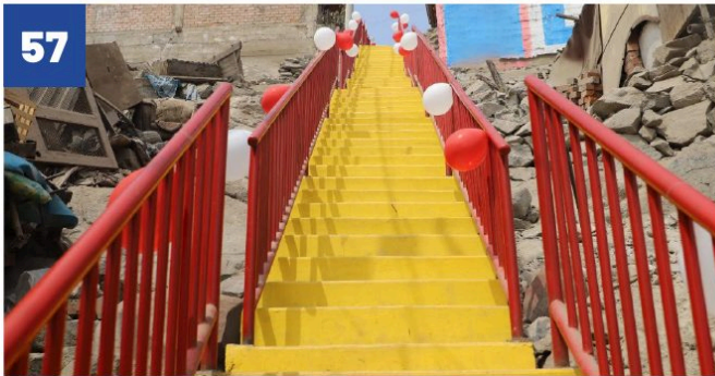
ESCALERAS PSJE. SAN JUAN AA. HH. LA ESTRELLA DEL VALLE AMAUTA
