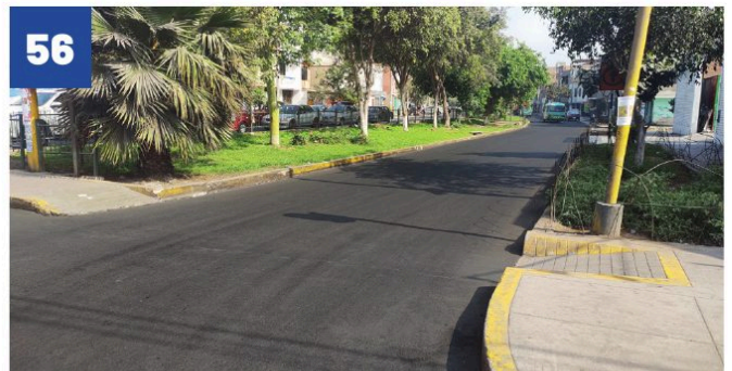
PISTA EN AV. METROPOLITANA, TRAMO ENTRE AV. SEPARADORA INDUSTRIAL Y AV. EL SOL, ASOC. PRO VIVIENDA FORTALEZA
