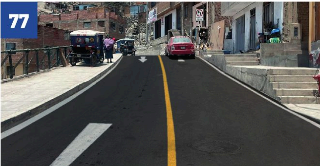
PISTA CALLE H DEL AA. HH. SANTA MARÍA
