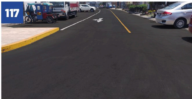
PISTA EN LA CALLE DUBLIN URB. JAVIER PRADO - V ETAPA
