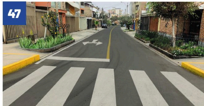
PISTA CALLE CATALUÑA
