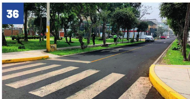
PISTA CALLE SANTA LUCÍA URBANIZACIÓN MAYORAZGO III ETAPA
