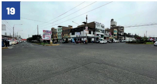
PISTA AV. LA MAR (TRAMO: AV. URUBAMBA - FRONTIS MZ D-2) COOPERATIVA DE VIV. 27 DE ABRIL
