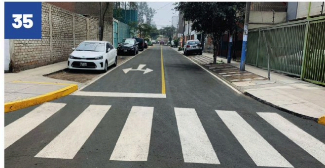
PISTA JR. NAVARRA URBANIZACIÓN MAYORAZGO III ETAPA
