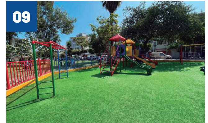
PARQUE GRAU E INSTALACIÓN DE JUEGOS INFANTILES URBANIZACIÓN MIGUEL GRAU
