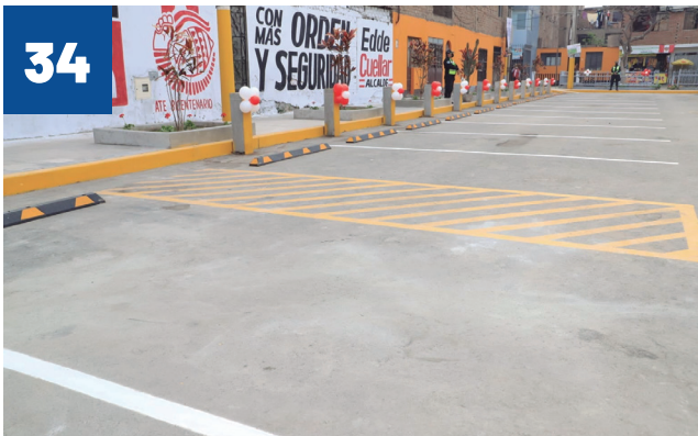
VEREDA Y ESTACIONAMIENTO CALLE 2 FUNDO VÁZQUEZ I Y II ETAPA GRUMETE MEDINA
